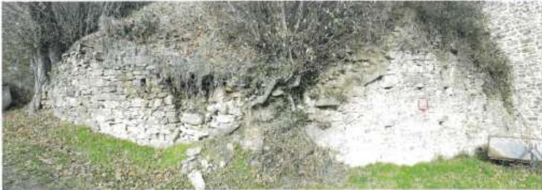
Mur de soutènement d'une propriété privée, belle construction dégradée par les racines d'un arbre
