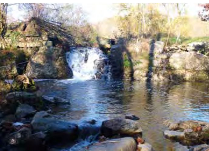
Le seuil de l'Aqueduc Romain du Gier - avant (petite vignette) et après les travaux - fait partie des 16 sites qui cloisonnaient le Garon entre sa confluence avec le Rhône et le barrage de Thurins.
